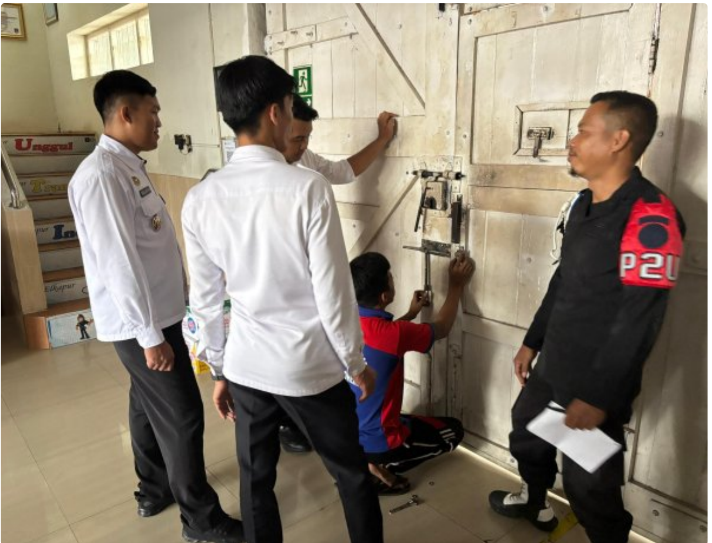
Garda Terdepan Keamanan, Lapas Narkotika Purwokerto laksanakan Perawatan dan Perbaiki Pintu Utama
